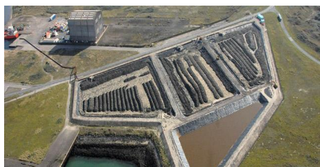
Slika 1. Sanitarna deponija za mulj
