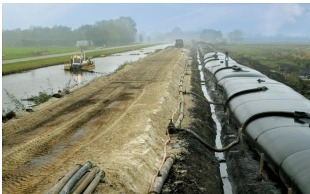
Slika 2. Postavljanje geotekstilnih vreća uz kanal
