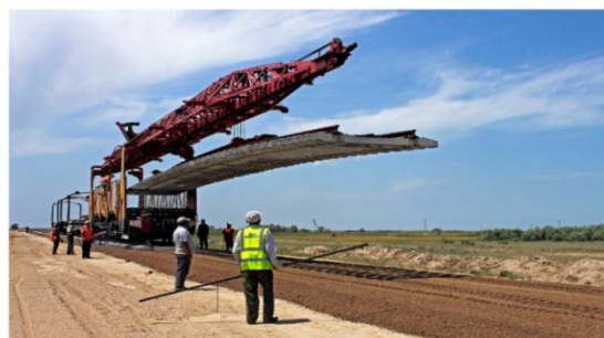
Slika 5. Kran za polaganje koloseka UK 25-28 [4]
