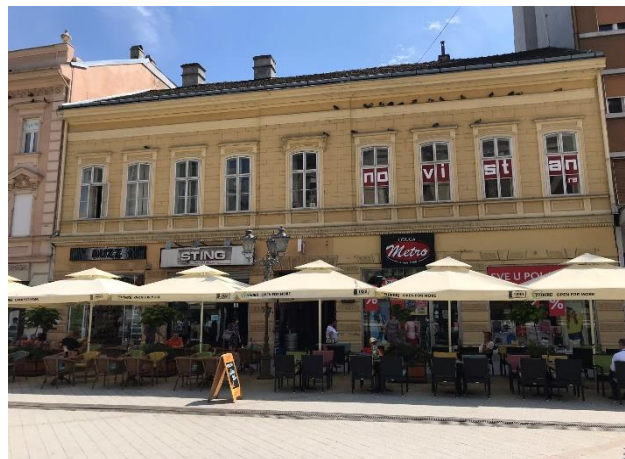
Slika 1. Ulična fasada predmetnog objekta
