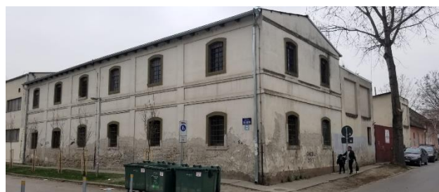
Slika 2. degradacija fasade starog dela
