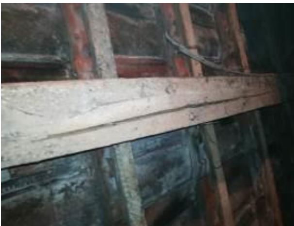
Slika 4. Drvena krovna konstrukcija
