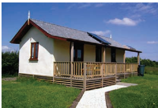
Slika 2. Kuća od balirane slame koja je testirana [3]
