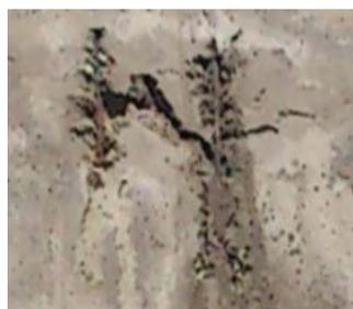
Slika 4. - Korozija armature i ljuskanje i otpadanje betona
