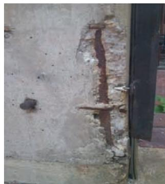
Slika 3. Korozija glavne armature i uzengija, Odvajanje i otpadanje betona
