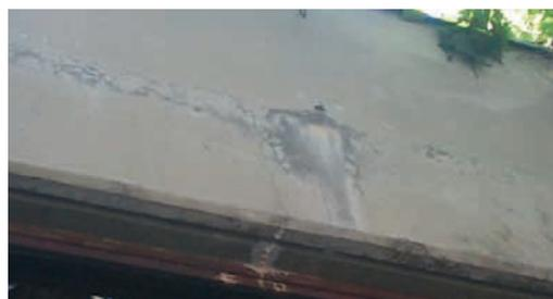
Slika 5. - Prsline, ljuskanje i otpadanje betona, rastvaranje i ispiranje  $\text{Ca(OH)}_2$  i taloženje  $\text{CaCO}_3$
