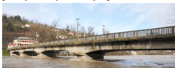
Slika 3. Izgled mosta pri visokom vodostaju Lima - uzvodna strana
