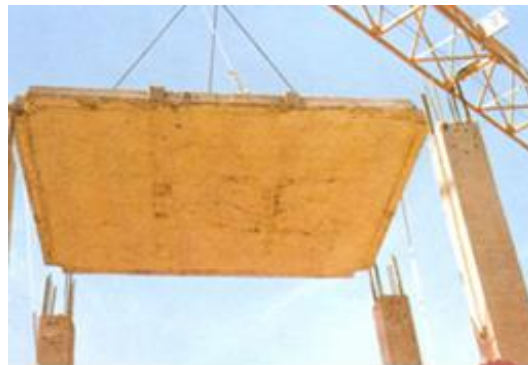
Slika 3. Montaža elemenata IMS sistema [8]
